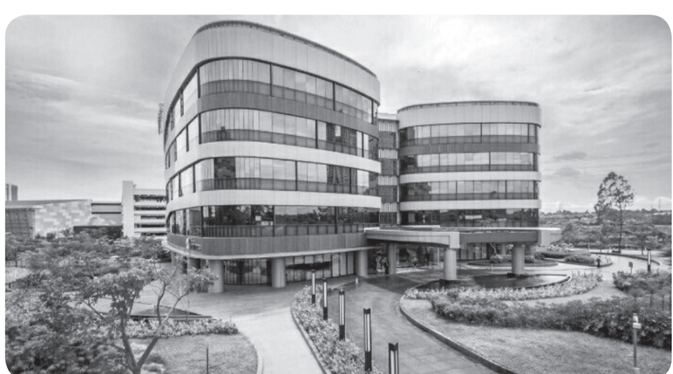
Gedung GOP 6 BSD City telah menggunakan material ramah lingkungan dan Energi Baru Terbarukan (EBT).
